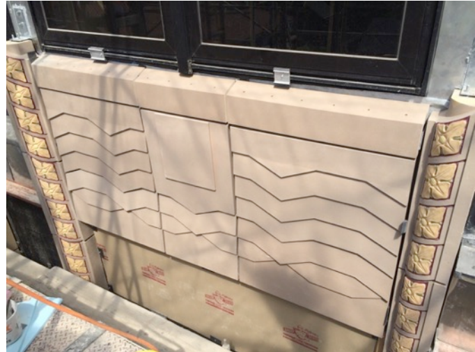
Fig. 5.70: Terra-Cotta Spandrel Installation Fig. 5.71: Terra-Cotta Spandrel
