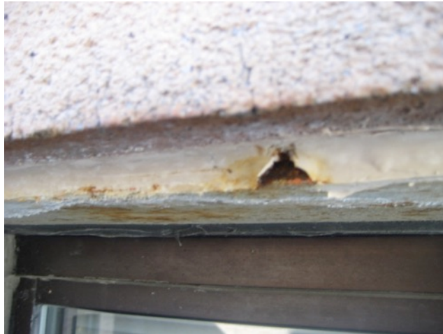
Fig. 3.66: Lintel Corrosion
