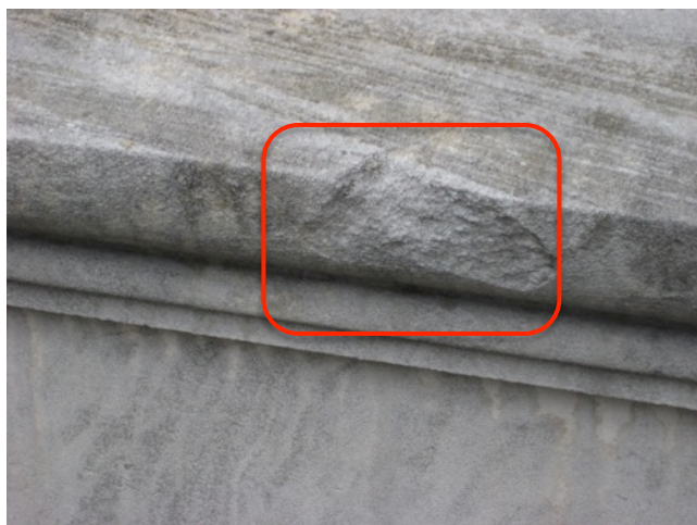
Fig. 3.37: Water-Table Edge Spall
