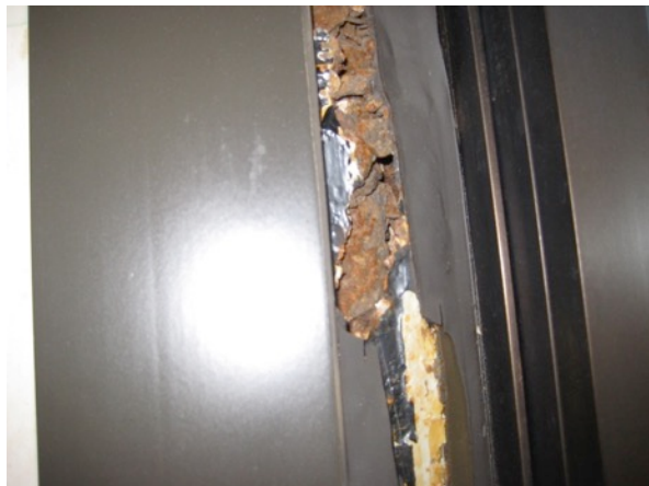
Fig. 3.69: Steel Jamb Corrosion
