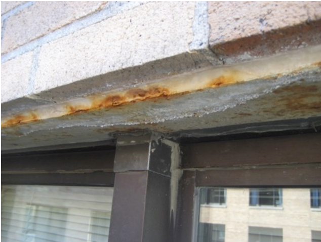
Fig. 3.65: Lintel Corrosion
